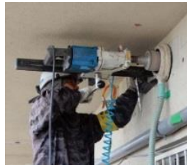
ホールソーによるRC造躯体への穿孔
