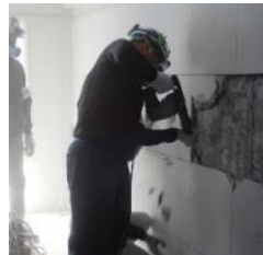
電動チッパーによる壁モルタルの研り
